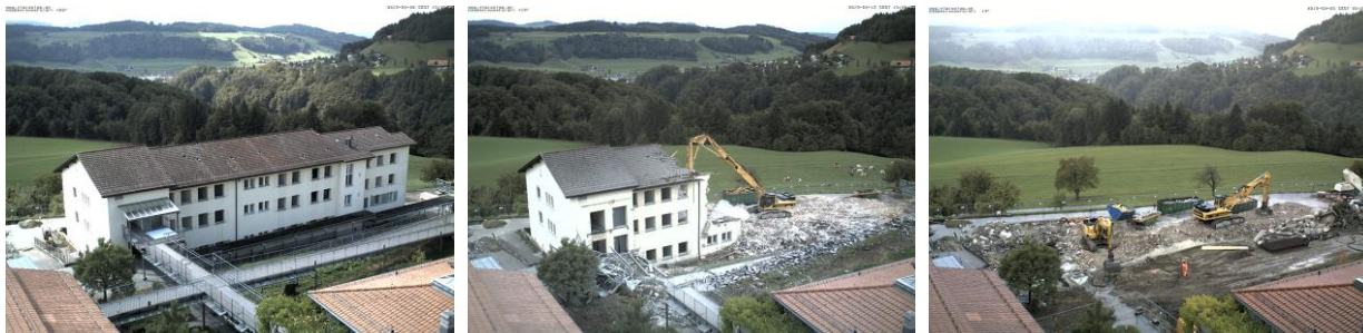
Rückbau Haus E im September 2015
