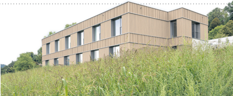
Der doppelstöckige Neubau
